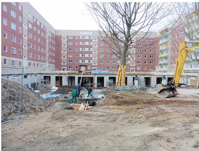
Innenhof mit entstehender Quartiersgarage.
