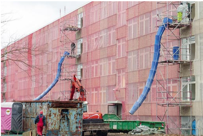
Die Arbeiten in der Mannheimer Straße laufen.
