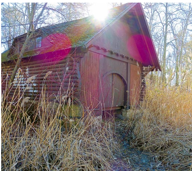
Als erstes soll das Bootshaus renoviert werden.
