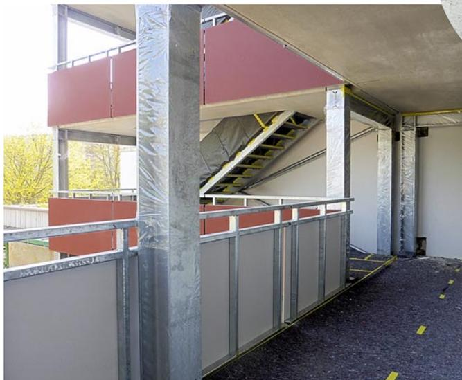
**Die neue 1,80 Meter breite Balkonanlage wird nach ihrer Fertigstellung auch die Funktion eines zusätzlichen Fluchtwegs erfüllen. Rechts oben einer der Nistkästen.**
