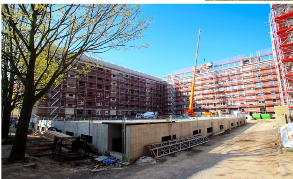
Im Innenhof der Wohnanlage »An der Kotsche« entsteht eine Quartiersgarage, deren Dach später begrünt wird.
