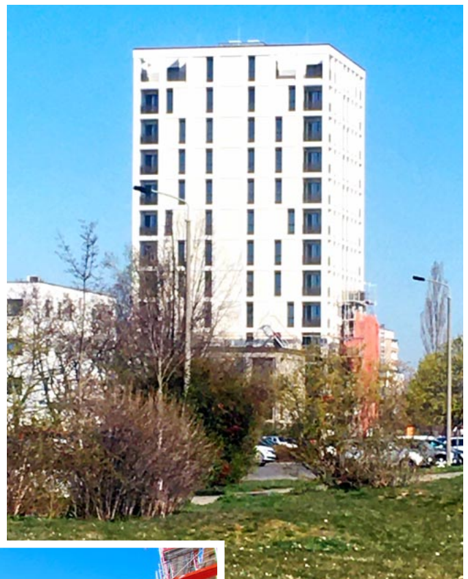
Der Lipsia-Turm in der Brackestraße steht kurz vor der Fertigstellung.
