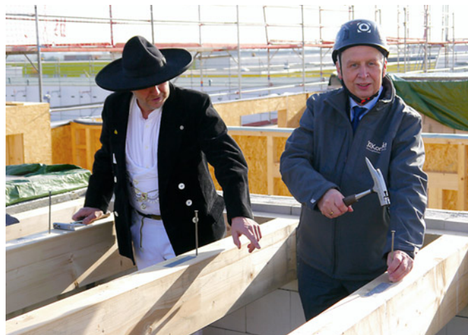
Der Vorstandsvorsitzende der WBG Kontakt, Jörg Keim, schlägt als Bauherr den letzten Nagel in den Dachstuhl.
