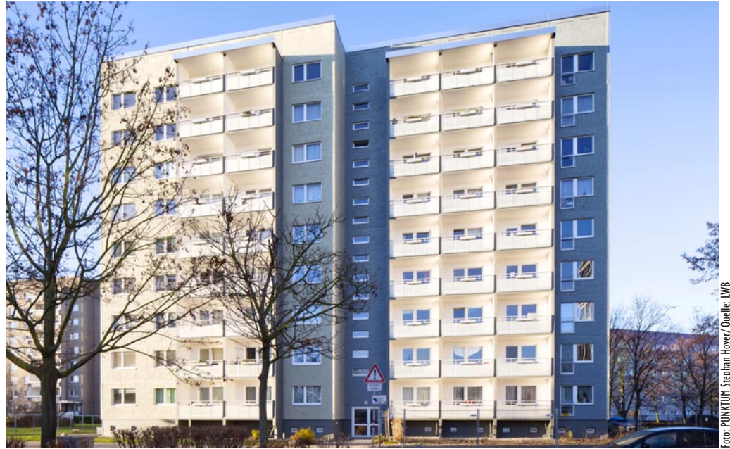
Die Sanierung im Titaniaweg 5 wurde bereits Ende 2020 abgeschlossen.
