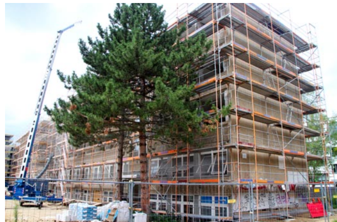
Im Entstehen: Der Campus Grünau am Militzer Weg 1-4.
