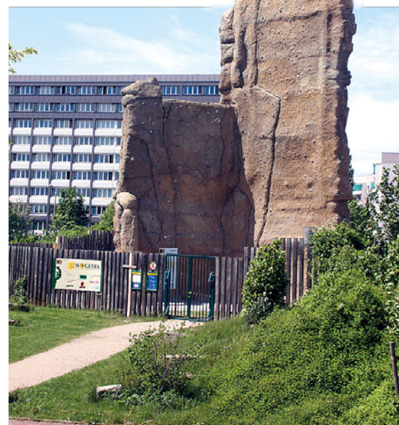
Der Kletterfelsen im WK 4 ist 21 Meter hoch und besteht aus Platten des abgerissenen PH 16 Garskestraße.
