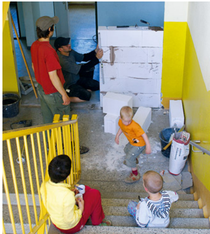
Alle packen an: Vor Eröffnung der Freien Schule wird das Haus von Eltern, Kindern und Lehrern renoviert.
