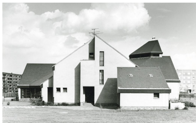
Neubau des katholischen Gemeindezentrum St. Martin in Grünau, 1980er.
